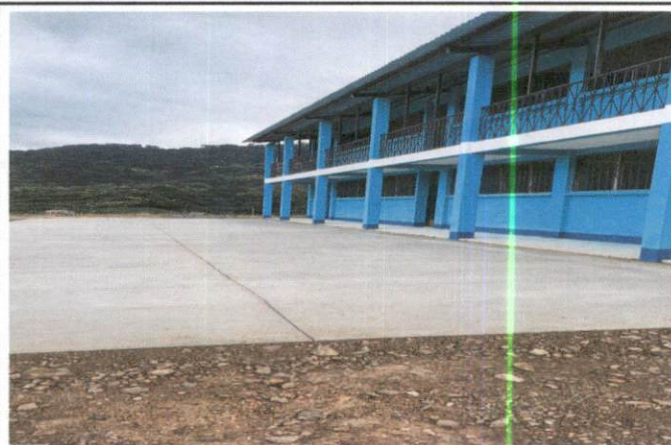
Foto 3: MEJORAMIENTO DE LOSA DE PATIO
